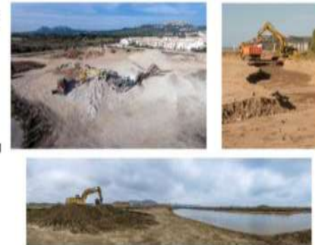
Imágenes de trabajos de retirada, excavación y demolición. 2015-2018
